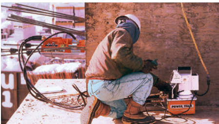
PE60-Pumpe im Einsatz bei Spannarbeiten.
