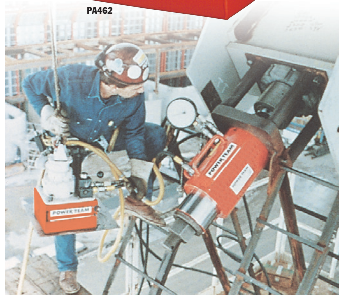
Die PA554-Pumpe im Einsatz mit dem Hohlkolbenzylinder RH2008 beim Spannen von Kabeln.
