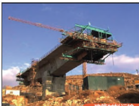
建筑材料运输
