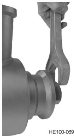
Kuva 37 - Akselin lukkomutterin asentaminen
