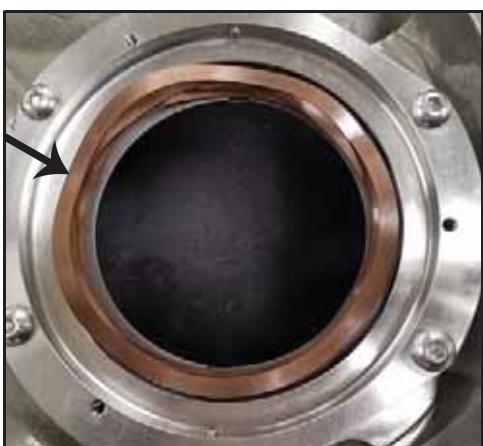
Figura 115 - Mola ondulada instalada
