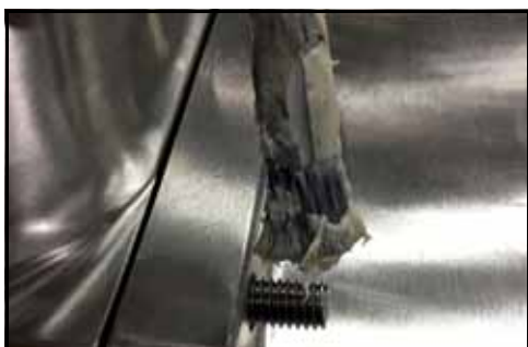
Figur 131 - Påføre gjengepasta på gjengene
